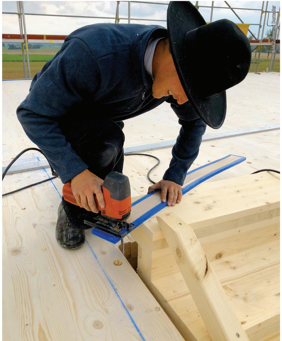
Bild 3: Die Dämmstreifen können mit einer Stichsäge zugeschnitten werden. Vorab ist die Position auf der Trenndecke angerissen worden.
