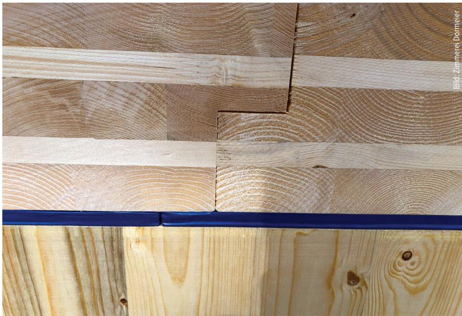
Bild 4: Zwischen der Stoßfuge der Dämmstreifen und der Stoßfuge der Holzbauteile ist ein Versatz vorzusehen, damit die beiden Stöße nicht direkt untereinander liegen.
