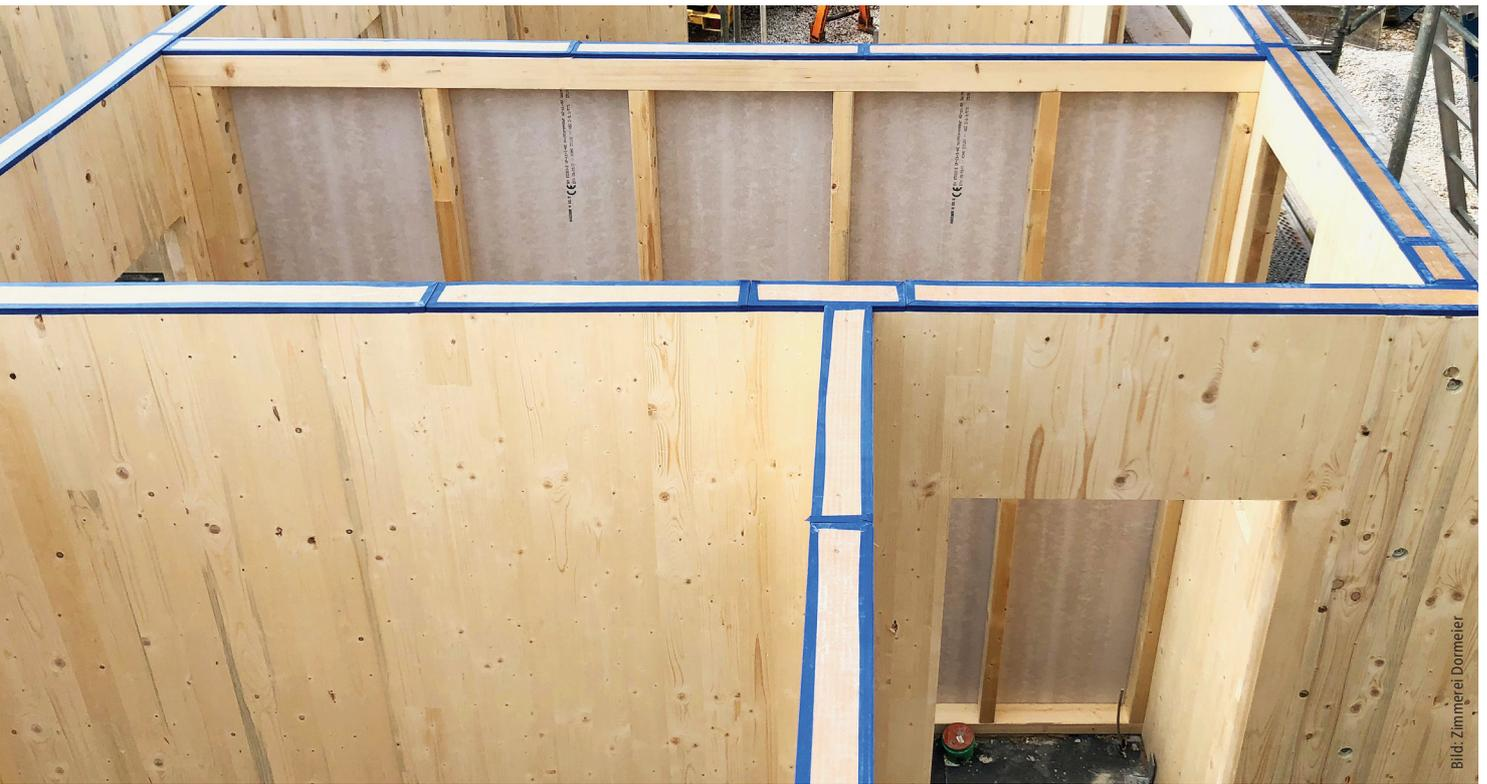
Bild 1: Mit entsprechenden Entkopplungsstreifen können die Nebenwege des Trittschalls über die flankierenden Wände deutlich eingedämmt werden.
