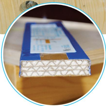
Bild 2: Der Entkopplungsstreifen Phonestrip im Querschnitt: Der Quarzsand wandelt als Funktionsschicht Schallwellen in kinetische Energie um.
